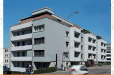
Spitalstr. 10+12+14 MFH mit 29 Wohnungen
