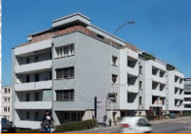
Spitalstr. 10+12+14 MFH mit 29 Wohnungen
